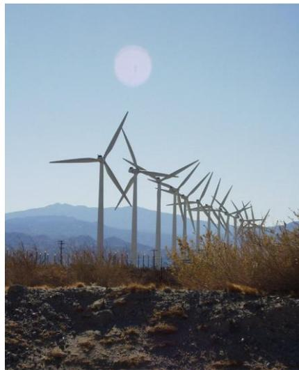
Lorsqu'il se met à souffler, le vent exerce un système de forces sur l'hélice qui, alors, se met à tourner. Les pales constituent ensemble le rotor. Les pales sont toujours orientées face au vent par un système de gouvernail. Suite aux mouvements des pales, un générateur va transformer cette énergie. Les habitations et autres bâtiments pourront ainsi recevoir l'énergie nécessaire à faire fonctionner les différents appareils électroménagers.
